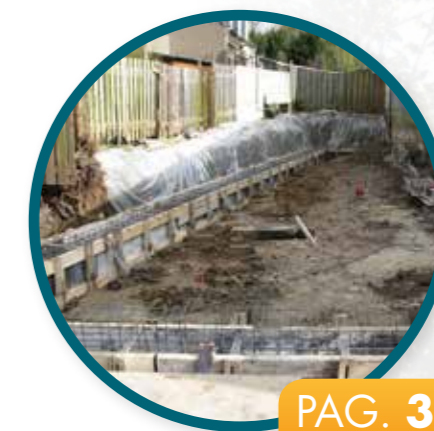
BOUWWERKZAAMHEDEN HOLLE EIK
